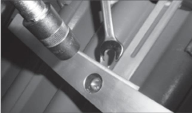
Fije riel al anclaje a techo con los bulones hexagonales incluidos M10 x 30 mm, arandela y tuerca.
