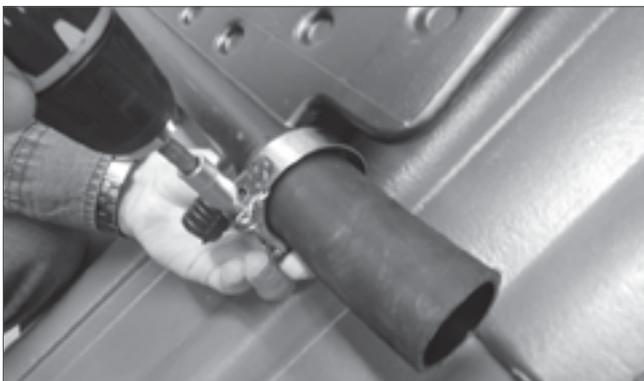
Empuje la manguera de conexión de 40 mm sobre la pieza de conexión del primer colector hasta el tope.
